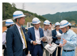
6月22日 新名神建設事故現場を視察
