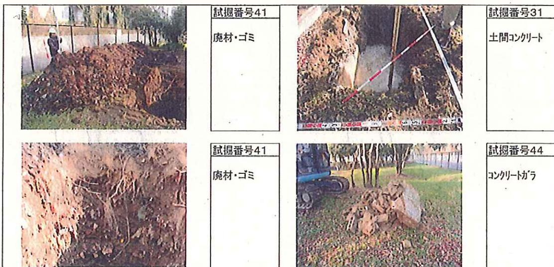
試掘番号 41 で確認された廃材・ゴミは生活用品が主で地表面からすぐに確認され削底部まで存在する。土砂と混ざったいわゆるミンチ状で異臭を放っている。この場所は地表面すぐから確認されたが、平均すると 1.5m～3.0m 間に層状に確認された箇所が多かった。これらは主に下図①の赤枠の区域内で確認され、区域南部では確認されなかった。
