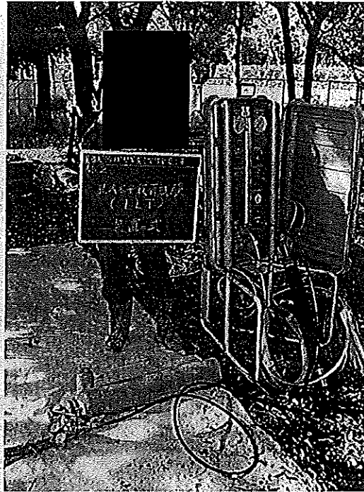
孔内水平載荷試験 (測定機材一式)
